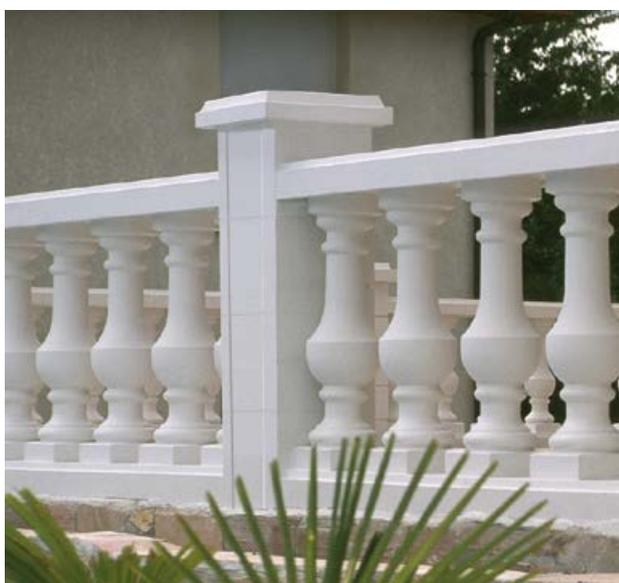
Balustres Royan 59 et éléments de Trumeaux Albâtre - Pose non alignée
