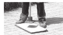
Compacter en utilisant une plaque protégée par un feutre.
