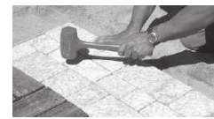
Ajuster la position des pavés à l'aide d'un maillet en caoutchouc.
