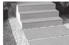
Pose sur gravillon.
